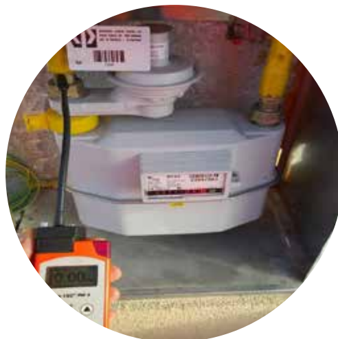
Redna kontrola glavnih požarnih pip
